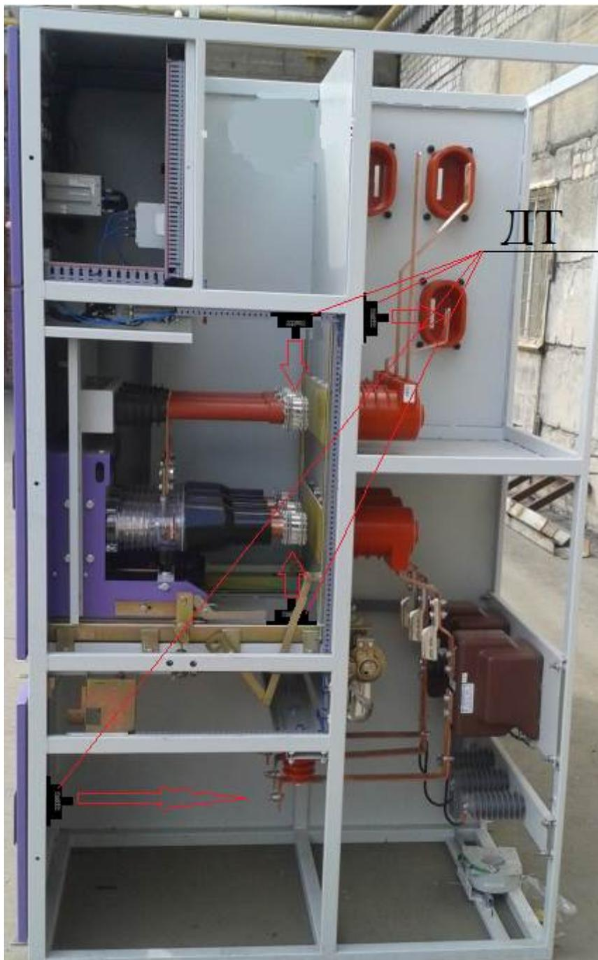
Рисунок В.1 – Примеры размещения ДТ-01 в ячейке КРУ
